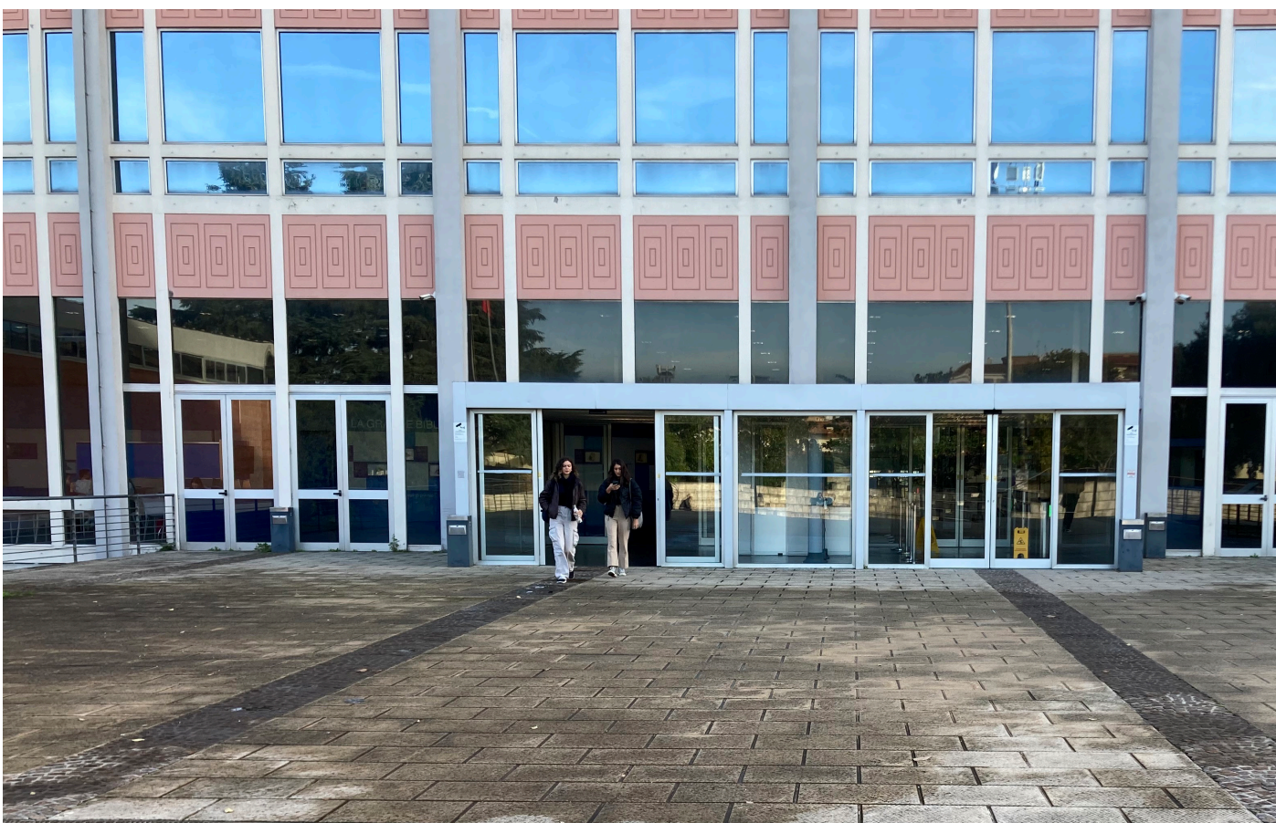
3) Ingresso : Il passaggio interno-esterno avviene senza dispositivi architettonici che garantiscano una protezione dagli agenti atmosferici
