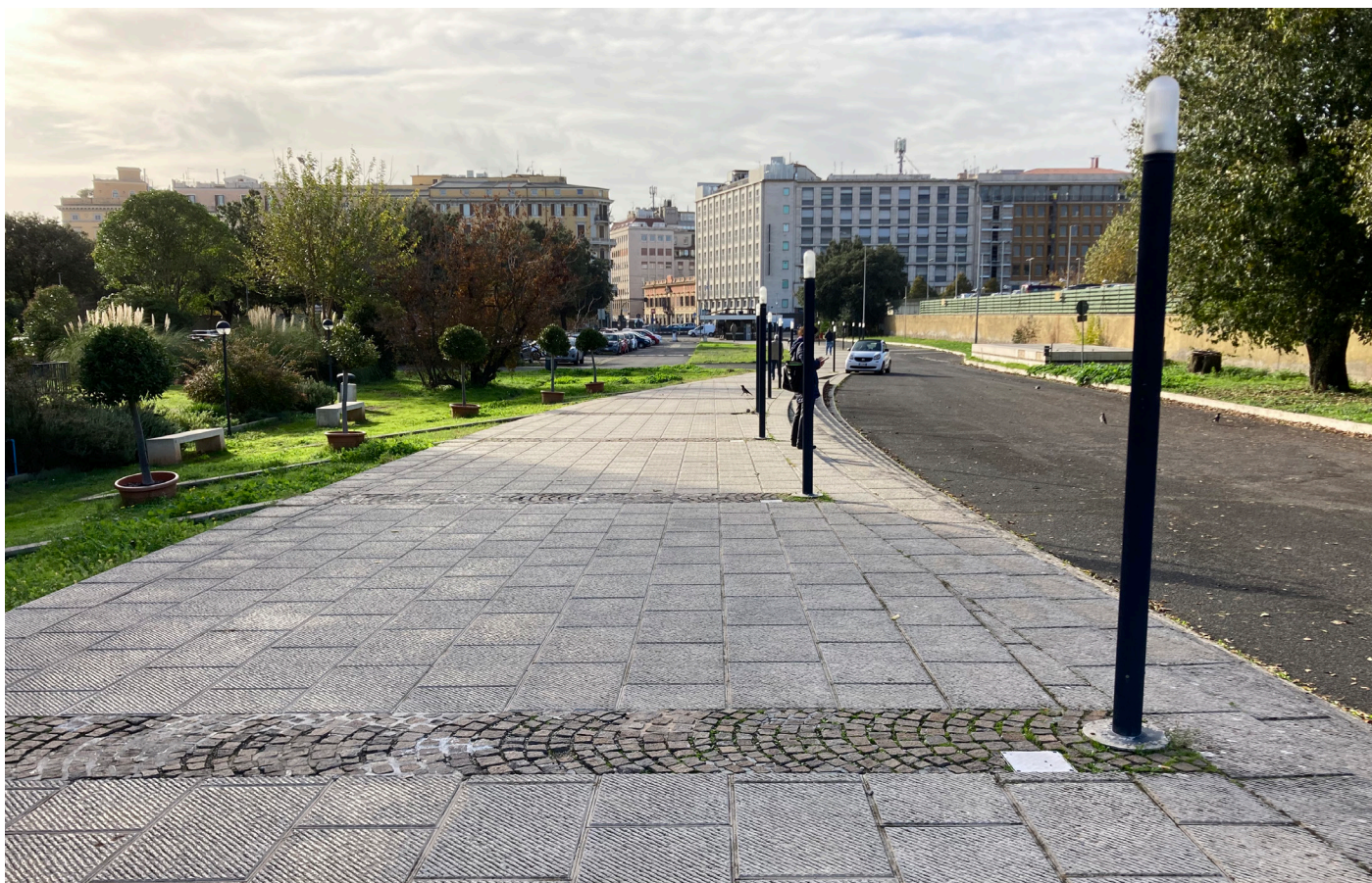
2.1) Superamento delle distanze : I lampioni potrebbero rappresentare un ostacolo fisico e costituirsi come fonte di pericolo
