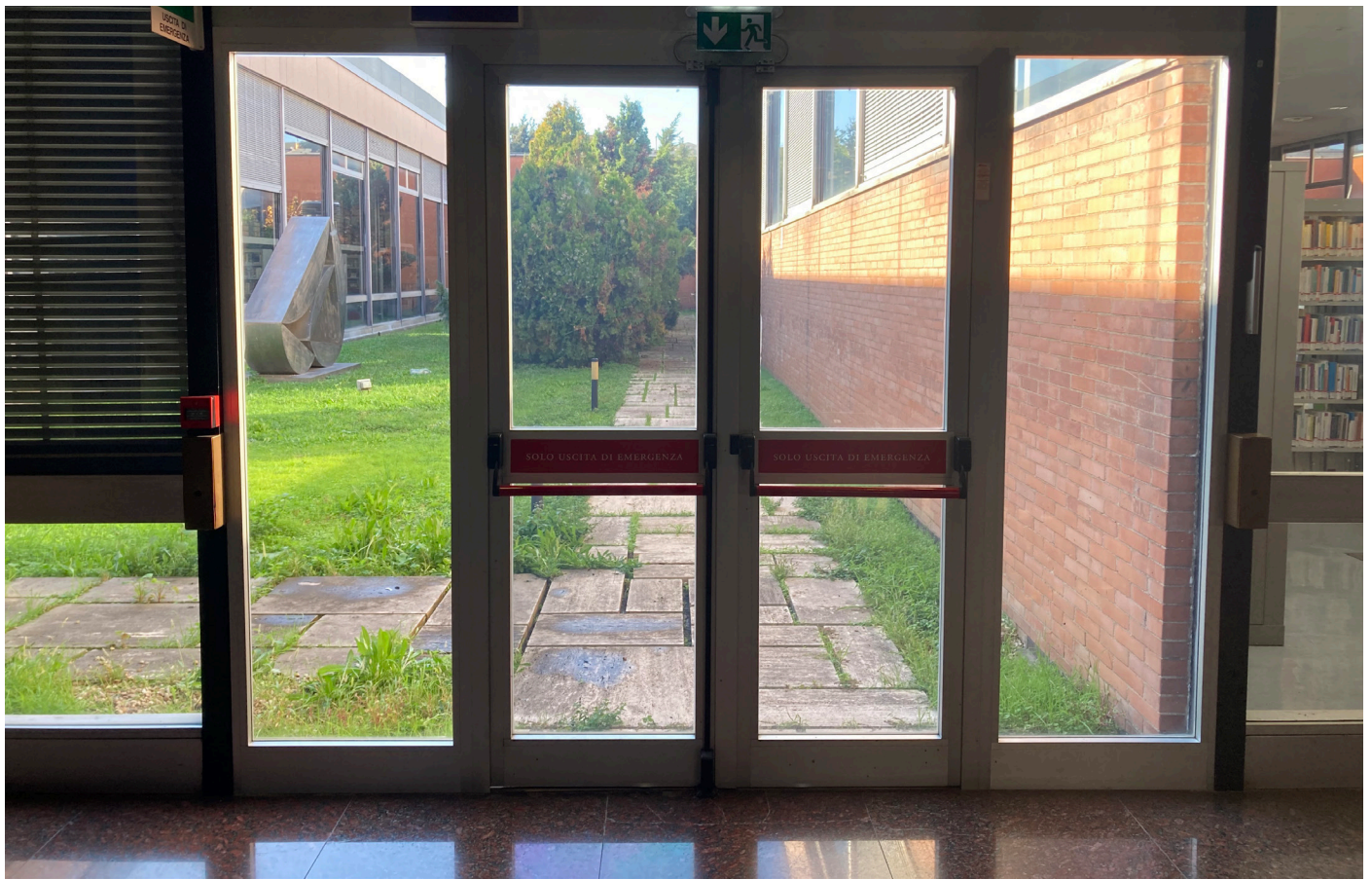
9) Pavimentazione nei luoghi sicuri statici
